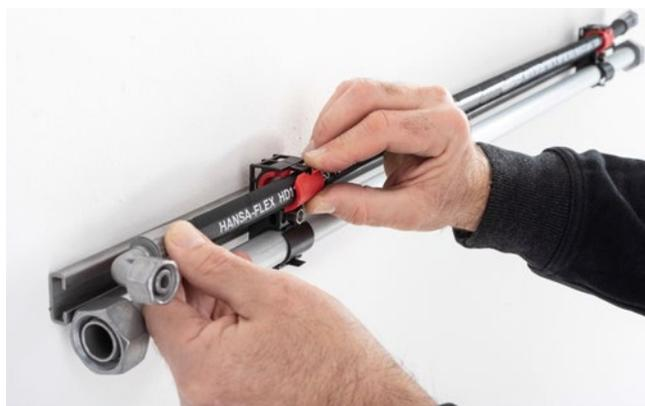
2. Rohr oder Schlauchleitung in die Schelle einklicken
